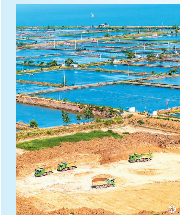
图①：洪泽湖周边滞洪区治理工程是治理淮河38项工程之一。5月16日，江苏省宿迁市泗洪县半城镇，洪泽湖周边滞洪区治理工程环湖大堤施工现场，施工单位正在紧张施工。
