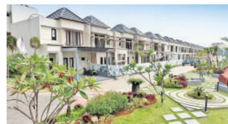
现代滨水住宅
