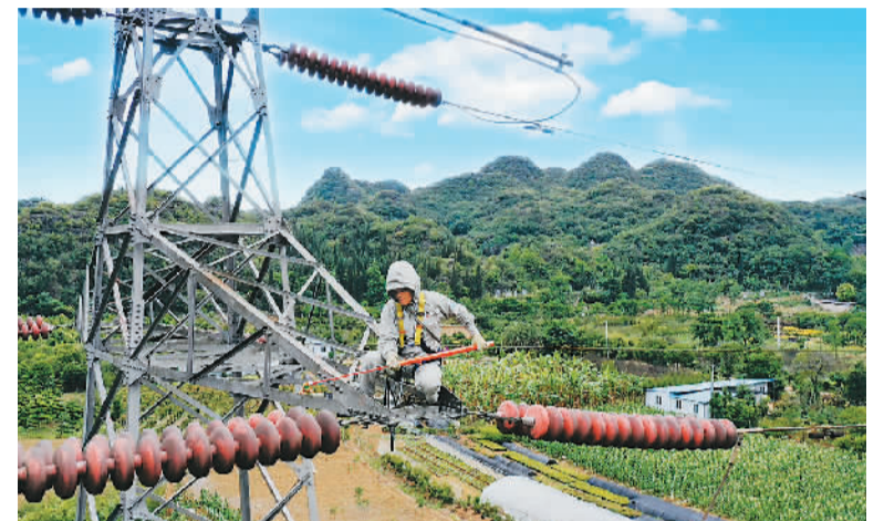
日前，南方电网贵州兴义供电局实施输电线路瓷质绝缘子零值检测工作计划，组织专业技术人员利用专业检测设备，在不停电情况下对相关线路设备进行检测，保障输电线路安全运行，为当地夏收夏种、居民生活和农业生产提供可靠用电。图为该局工作人员正对输电线路进行检测。
