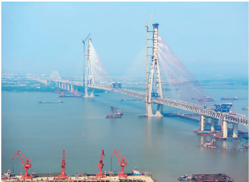
常泰长江大桥建设作业现场。 赵振宇摄（人民视觉）
