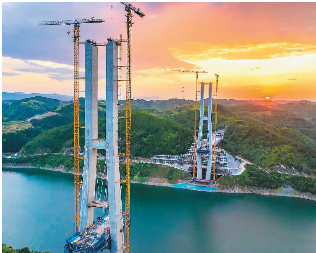
日前,西(安)十(堰)高铁汉江特大桥正在快速推进建设。该大桥位于湖北省十堰市,全长九百一十七点四五米。西十高铁设计时速三百五十公里,开通后西安至十堰将实现一小时内到达,西安至武汉将实现二点五小时左右到达。图为大桥建设现场。 金伟摄(人民视觉)
