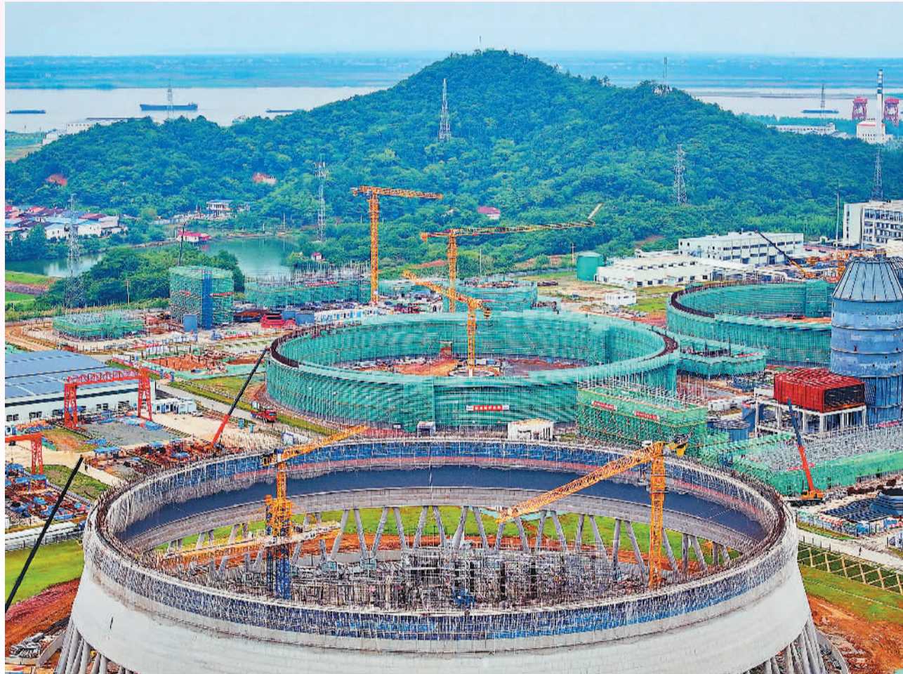
▲六月四日，江西省九江市湖口县高新技术产业园的一家火力发电厂二期项目建设点塔吊林立，工人在加快推进冷却塔、塔筒、配套厂房等项目工程建设。 朱海鹏摄（人民图片）
